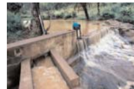
▲ Malá vodní elektrárna zásobující keňskou vesnici elektřinou, která postačuje k osvětlení obydlí.
