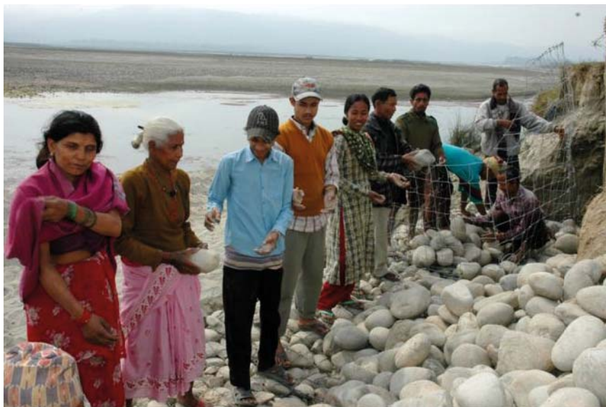
Fotografie: Stavba gabionu v nepálské oblasti Nawalparasi poté, co došlo k zaplavení tradičních zavlažovacích kanálů.
