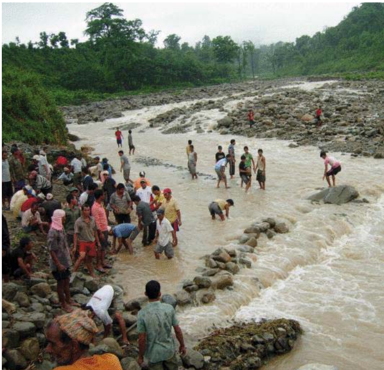
Oprava protizáplavových zábran, projekt Mainstreaming omezení rizika vzniku katastrof ohrožujících obživu, projekt Zabezpečení zdrojů obživy v Nepálu.
